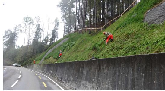
Bilder 18 und Nr. 19: nicht immer sind die Ausgaben im Strassenbau planbar: Sicherungsmassnahmen in der Sonderau, Hundwil, an der Kantonsstrasse Nr. 11, Hundwil – Stein. Immer wieder fielen Steine aus der verwitterten Felsböschung auf die Strasse und bedrohte den Verkehr. Nachdem sich ein grösserer Brocken löste, mussten im Frühjahr 2016 für rund Fr. 250'000.- die grossen Bäume gefällt und der Felsen mit Stahlnetzen gesichert werden. Anschliessend wurde eine Begrünung aufgebracht.
