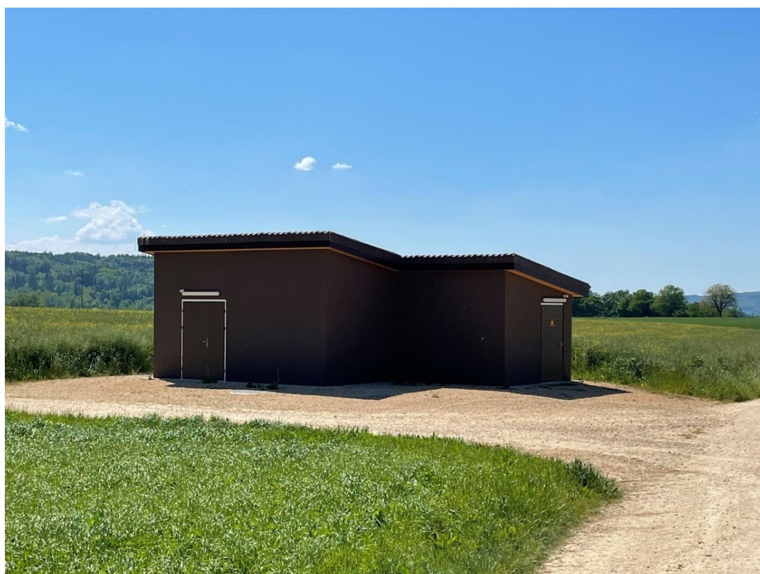
Abbildung 13: Beispiel Pumpstation «Bäumli 2»
