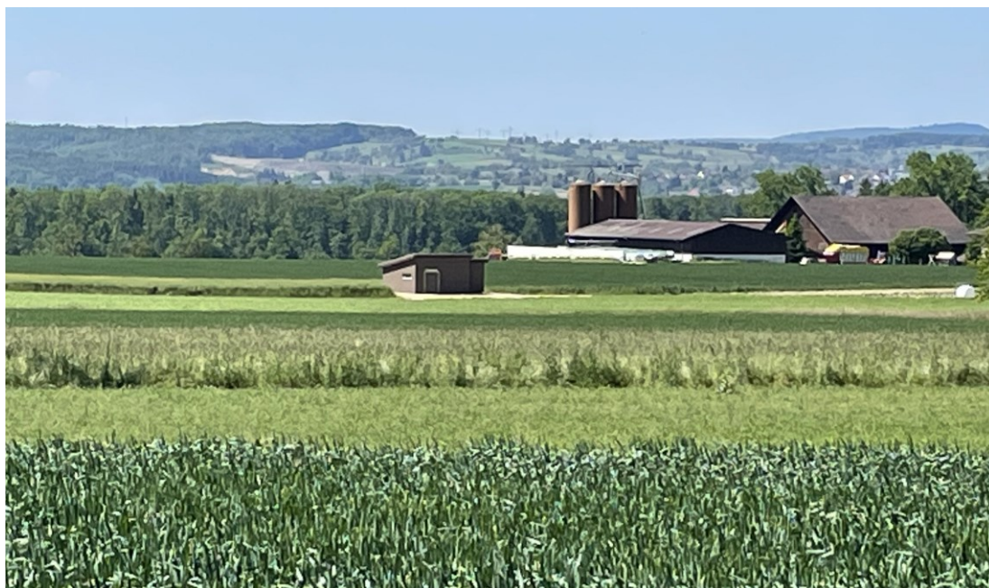
Abbildung 14: Beispiel Pumpstation «Bäumli 2», farblich in Umgebung integriert
