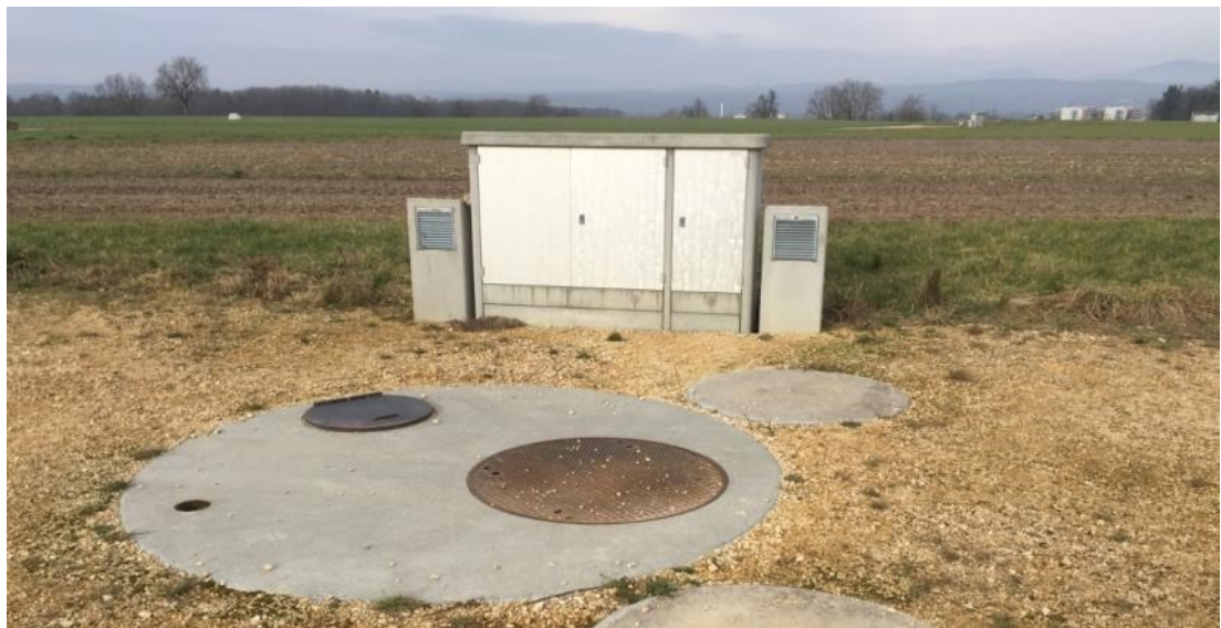
Abbildung 21: Bohrplatz während Betriebsphase (Oben: Schema)
