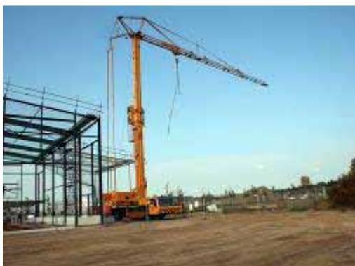
Photographie 10 (grue à tour pivotante): **les grues à tour automontante sur camion** sont difficiles à classer dans une des deux catégories, leur partie inférieure appartenant aux camions-grue et leur partie supérieure aux grues à tour pivotante. En général, leur utilisation uniquement pour le levage nécessite un permis B (grues à tour pivotante) tandis que l'installation seule ou l'installation et le levage requièrent un permis A (camions-grue).
